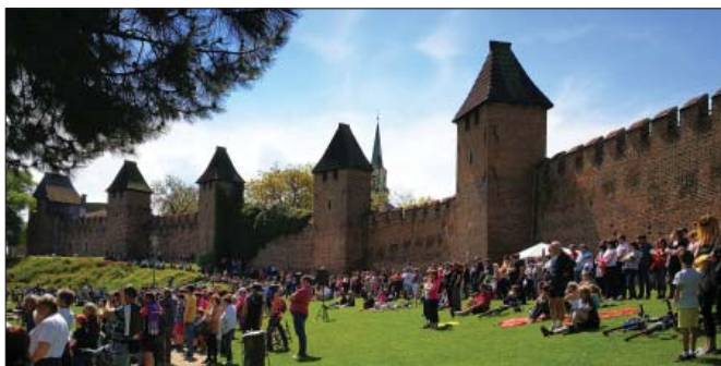
An der Stadtmauer von Nymburk
